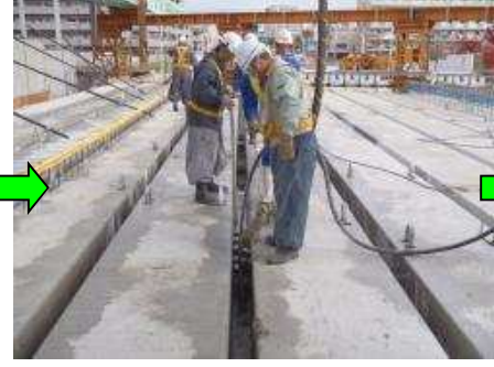
【横組コンクリート打設】
