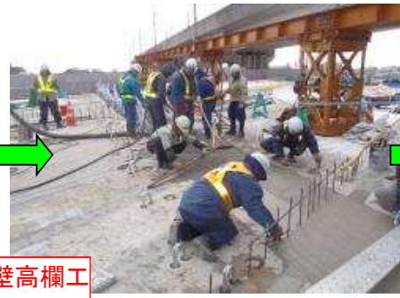
【連結コンクリート打設】
