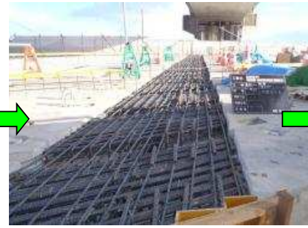
【連結鉄筋組立完了】
