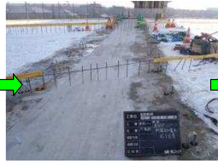
【連結コンクリート打設完了】
