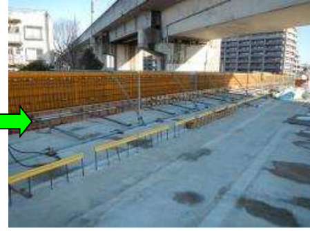
【地覆・壁高欄型枠組立】
