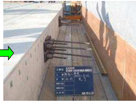
【横組PC鋼線緊張完了】
