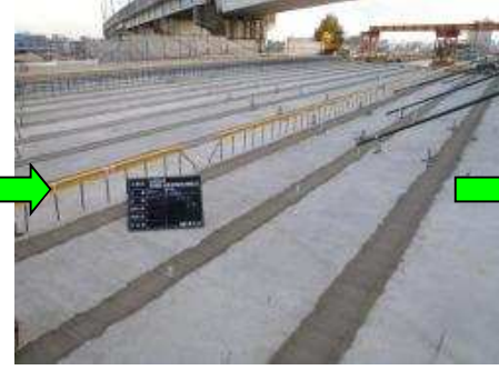
【横組コンクリート打設完了】
