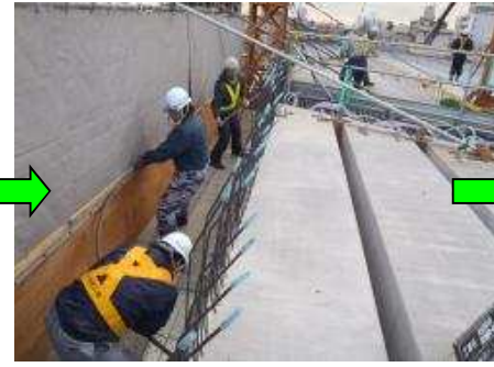
【横組PC鋼線挿入】
