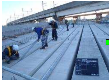
【主桁間埋設型枠設置】
