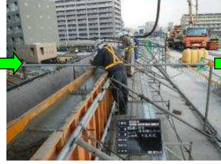
【地覆・壁高欄コンクリート打設】
