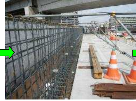
【地覆・壁高欄鉄筋組立】
