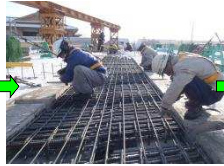
【連結鉄筋組立】
