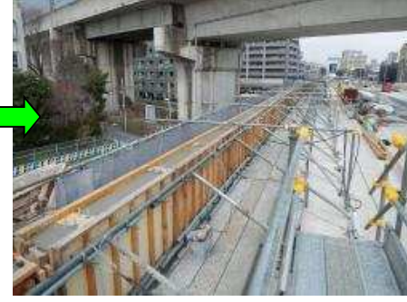
【地覆・壁高欄コンクリート打設完了】
