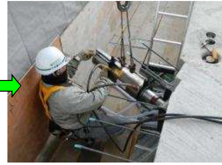
【連結PC鋼線緊張】
