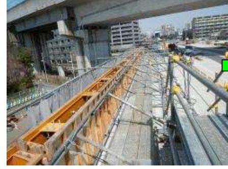
【地覆・壁高欄型枠組立完了】
