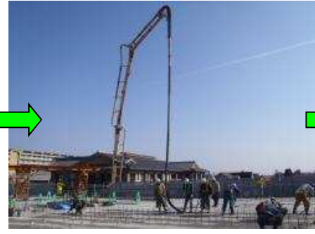
【横組コンクリート打設】
