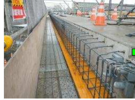
【地覆・壁高欄施工前】
