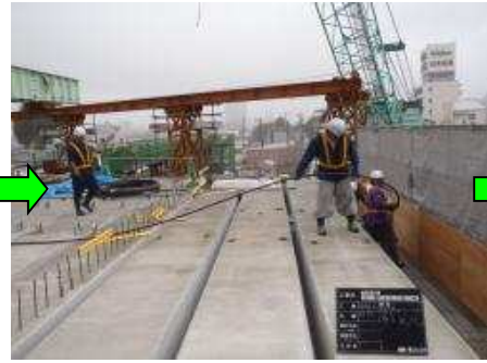
【横組PC鋼線挿入】
