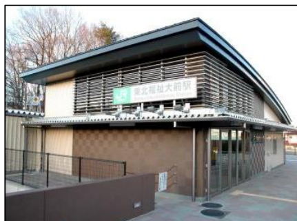
【JR東北福祉大駅】 □場所: 宮城県仙台市 □竣工年: 2007/3
