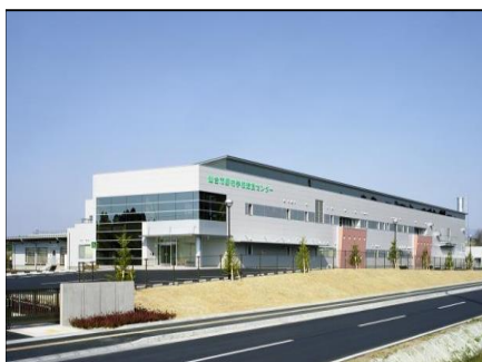
【仙台市野村学校給食センター】 □場所:宮城県仙台市 □竣工年:2008/3
