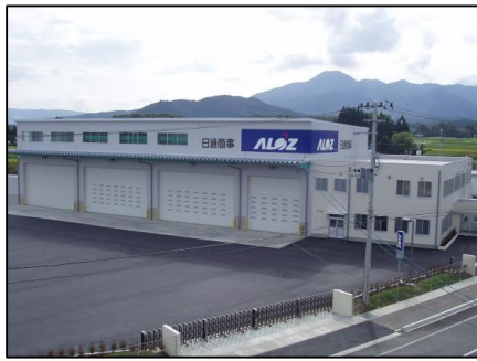
【日通商事(株)盛岡支店整備工場】 □場所:岩手県紫波郡 □竣工年:2007/9
