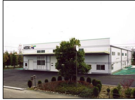
【ケディカ東工場】 □場所:宮城県仙台市 □竣工年:2007/12
