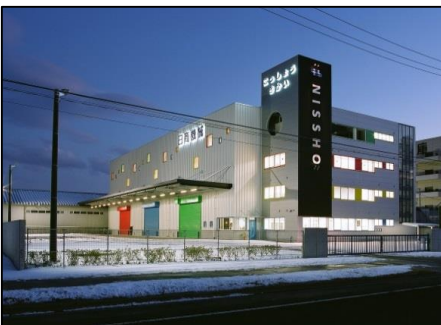
【日商機械仙台リースセンター】 □場所:宮城県仙台市 □竣工年:2012/4
