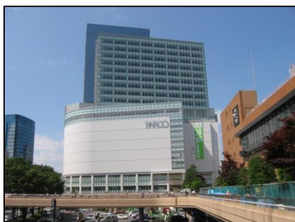
【仙台マークワン】 □場所:宮城県仙台市 □竣工年:2008/8
