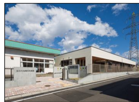
【仙台市向陽台児童館】 □場所：宮城県仙台市 □竣工年：2015/3
