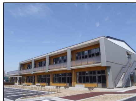
【鏡石町立第一小学校】 □場所：福島県鏡石町 □竣工年：2014/1
