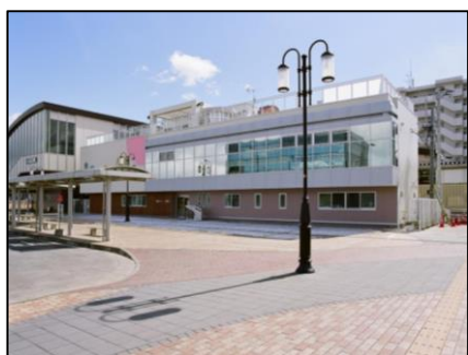
【新田東すいせん保育所】 □場所：宮城県仙台市 □竣工年：2011/3
