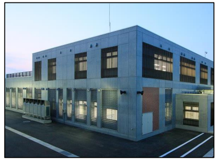
【日本通運青森支店警送事業所】 □場所:青森県青森市 □竣工年:2009/6
