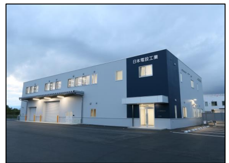
【NDK盛岡ビル】 □場所:岩手県盛岡市 □竣工年:2016/9
