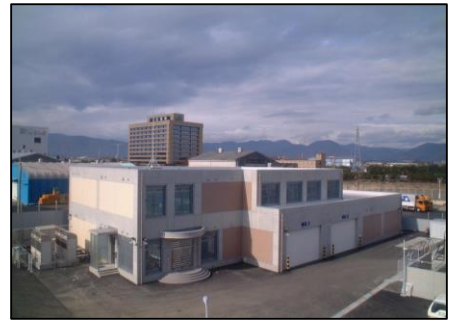
【日本通運(株)福島支店警送事業所】 □場所:福島県福島市 □竣工年:2007/11
