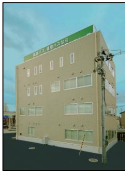
【JRバス東北仙台支店】 □場所:宮城県仙台市 □竣工年:2008/3
