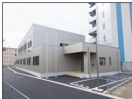
【東日本電気エンジニアリング(株)郡山信号通信・電力サービスセンター】 □場所:福島県郡山市 □竣工年:2015/10
