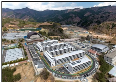
【女川町運動公園住宅】 □場所: 宮城県牡鹿郡女川町 □竣工年: 2014/3
