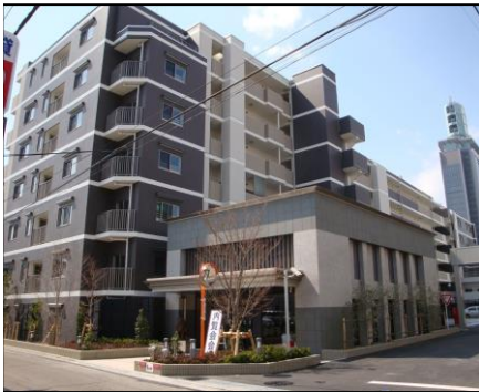
【ライオンズ仙台上杉レジデンス】 □場所: 宮城県仙台市 □竣工年: 2009/4
